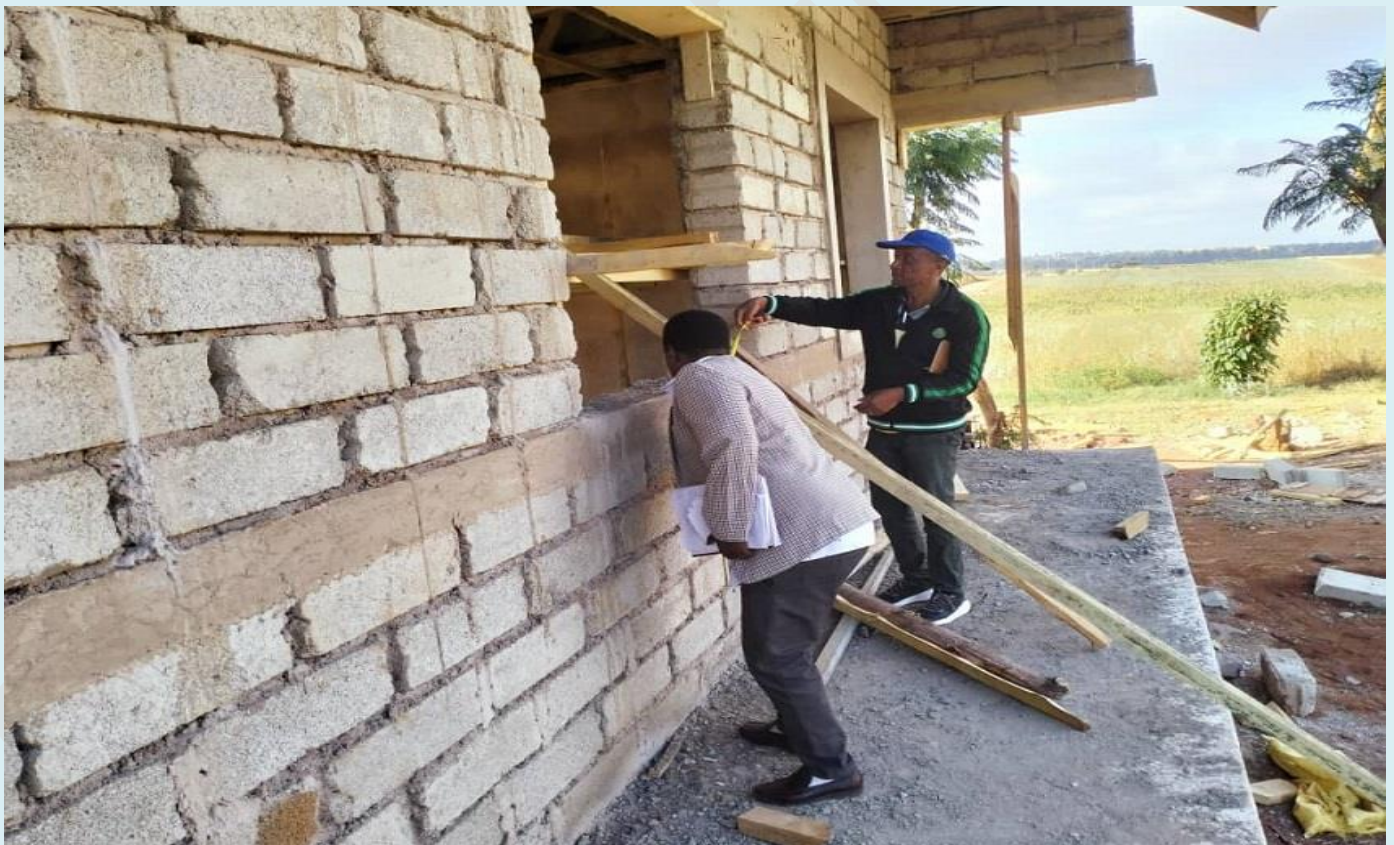
Mwenyekiti wa Halmashauri ya Wilaya ya Siha Mhe. Duncan Urassa (kulia) akiwa na Mhandisi wa Ujenzi Halmashauri ya Siha Sospeter John wakikagua ujenzi wa madarasa katika shule ya Msingi Lemosho Kata ya Ndumeti
