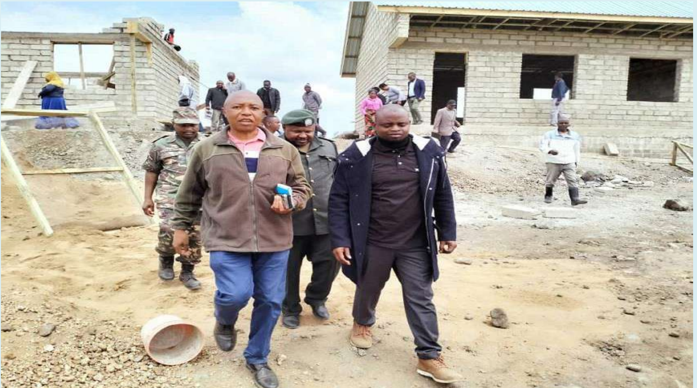
Mkuu wa Wilaya ya Siha Mhe Dkt. Christopher Timbuka (kushoto mbele) akiwa na Mkurugenzi Mtendaji Dkt. Haji Mnasi (kulia) wakitembelea mradi wa ujenzi wa shule mpya ya Leng'ong Kijiji cha Magadini Kata ya Gararagua tarehe 12/7/2023
