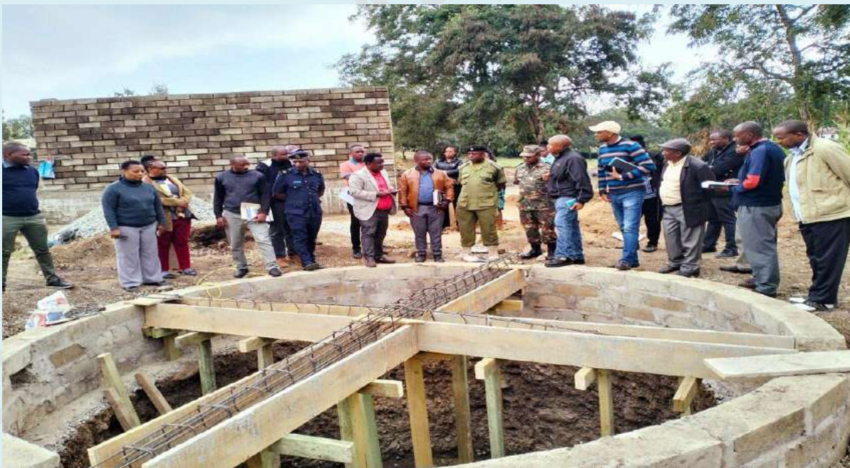
Mkuu wa Wilaya Dkt Timbuka (tano kulia mbele) akiwa na viongozi wengine walipotembelea ujenzi wa madarasa 7,mabweni mawili na matundu ya vyoo 14 katika shule ya sekondari Sanya Juu tarehe 13/7/2023. Shule ya Sekondari Sanya Juu imepokea kiasi cha shilingi milioni 464.4 kutoka Serikali ya Jamhuri ya Muungano wa Tanzania
